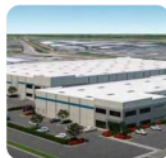
DERMODY – Plateforme de Logistique (US)
