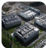
DATA 4 – Plateforme DATACENTER (UE)
